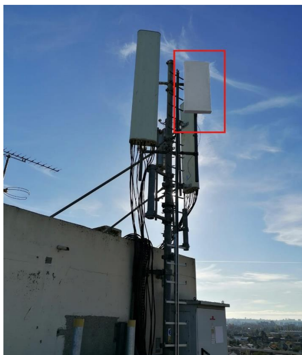
Vue de la terrasse S0 après travaux
