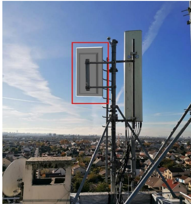
Vue de la terrasse S2 après travaux
