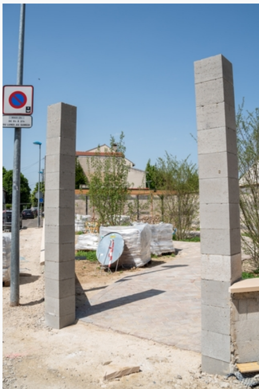
Les travaux dans le square de la Paix
